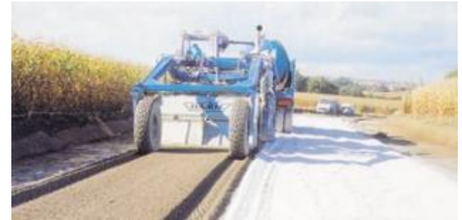
Malaxage en place
