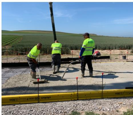
⬆ Bétonnage : alimentation du béton à la pompe, régalage au râteau, suivi du serrage du béton à l'aiguille vibrante.
