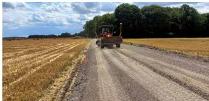
↑ Réglage des fraisats d'enrobés et mise au profil à l'aide d'une niveleuse guidée par GPS. (©Colas)
