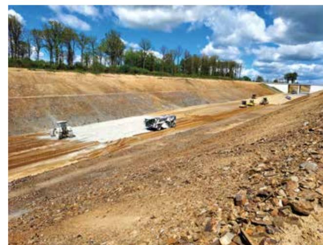
De gauche à droite et de haut en bas ↑ Un malaxeur Wirtgen WR 240i a permis le malaxage du matériau et du liant Rolac Premier ECOPlanet. ↑ L'arroseuse à enfouissement garantit une teneur en eau optimale. ↑ Réglage à la niveleuse pour obtenir un profil en long très régulier et atelier de compactage de la couche de forme traitée pour atteindre la compacité exigée. ↑ Vue générale du chantier de traitement de la couche de forme. (©Guintoli - NGE)
