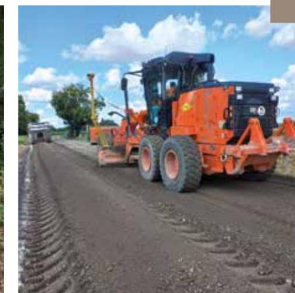
De gauche à droite ↑ Un atelier de compactage en action. ↑ Le retraitement au LHR est suivi par un nivellement et par la mise au profil du matériau. (©Colas)
