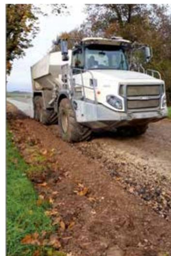
De gauche à droite ↑ Épandage du liant Ligex M10 à raison de 35 kg/m<sup>2</sup> (dosage 5%) à l'aide d'un épandeur moderne doté d'un système de dosage volumétrique asservi à la vitesse d'avancement. (©Ludovic Padeloup/Conseil départemental de la Vienne)
