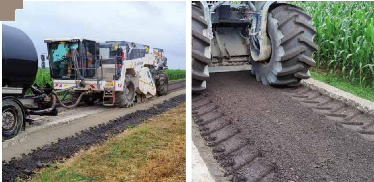
De gauche à droite ↑ Section 3. Atelier de retraitement mixte au liant ROC VDS (liant épandu au sol) et à l'émulsion de bitume (injectée directement dans la cloche du malaxeur). ↑ Section 2. Atelier de retraitement partiel à l'émulsion de bitume du matériau déjà retraité au liant ROC VDS. (©Colas)
