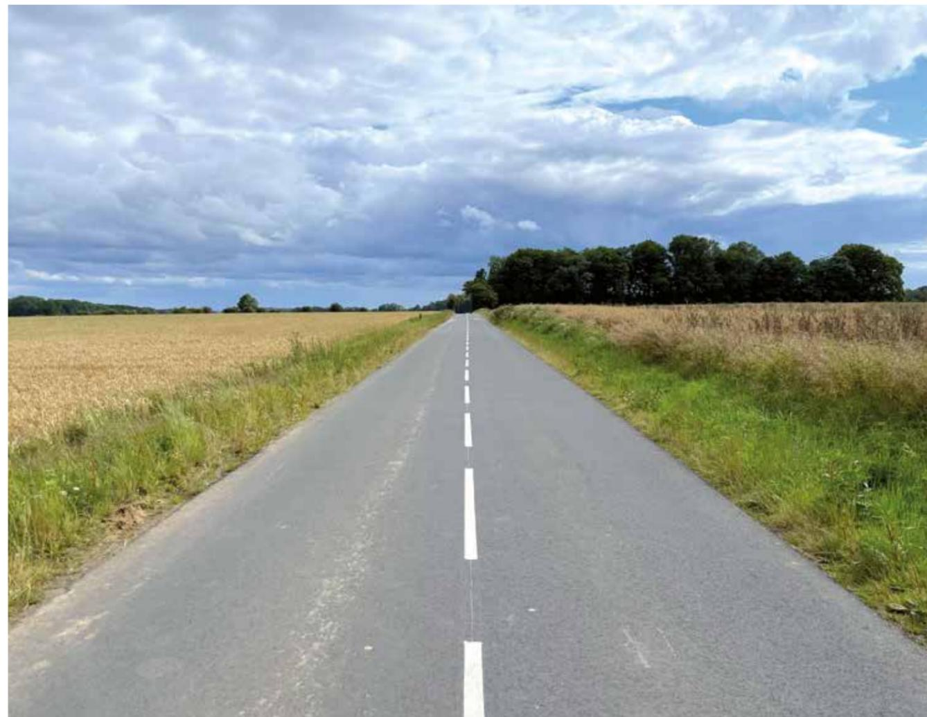
↑ Réhabilitation de la RD119 achevée. Accotements rehaussés et signalisation horizontale réalisée. (©Fenêtre sur cour)
