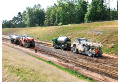
Le traitement a été effectué sur 35 cm de profondeur et 14 m de largeur.
