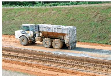
En quatre jours, 800 tonnes de liants Rolac Flex de Lafarge, provenant de l'usine d'Angoulême, ont été mises en œuvre.
