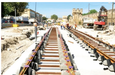
Les rails posés sur des traverses biblocs en béton, préfabriquées par Sateba. En gros plan, à droite, la partie sous patin de l'habillage des rails en mousse polyuréthane. Ces pièces (semelles élastiques) garnissent les rails avant le coulage du béton de calage. D'autres pièces viendront garnir les flancs du rail avant le coulage du béton de revêtement.
