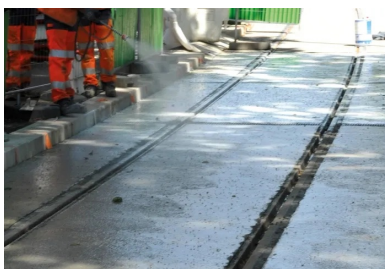
Lavage à haute pression du béton désactivé.
