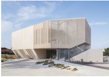
Pour renforcer l'image d'un cristal de roche équerrié, le bâtiment a été réalisé avec comme unique matériau le béton.
