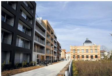
Vue générale du château de Nanterre. Au premier plan, les allées extérieures en béton décoratif réalisées entre mai et juin 2017.
