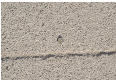
Le revêtement du parvis a été réalisé en Artificio® Bouchardé.
