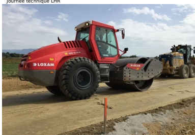
Retraitement des chaussées en place aux liants hydrauliques routiers
