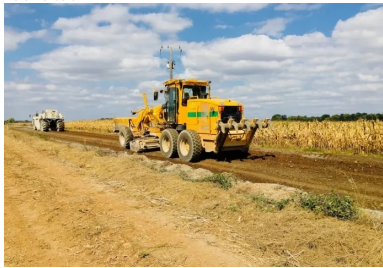
chantier de la RD7
