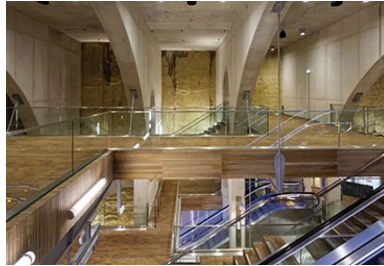
Jeu de contrastes des bétons bruts : les arches en béton blanc et les parois moulées.
