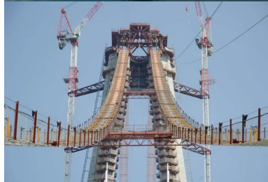
Les pylônes sont de section triangulaire variable...
