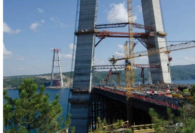
Le pylône européen est fondé sur la rive, non dans l'eau.
