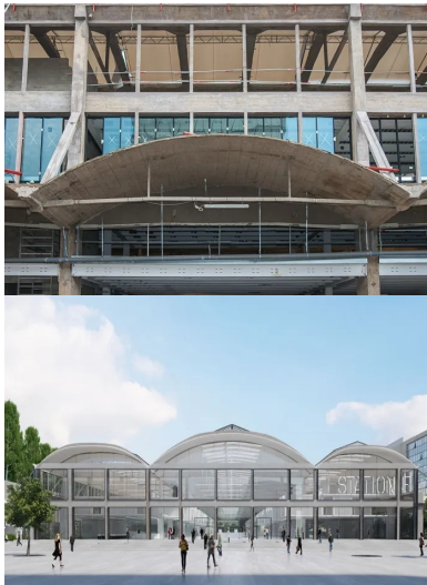
La légèreté de la structure est due aux auvents suspendus et stabilisés par des tirants métalliques noyés dans le béton.
