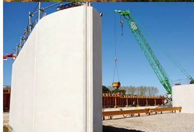
Une pile du futur viaduc (576 m) du Lez et de la Lironde.
