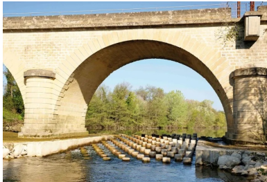
Un suivi environnemental a été assuré pendant toute la durée des travaux qui ont eu lieu de mai à septembre 2014.
