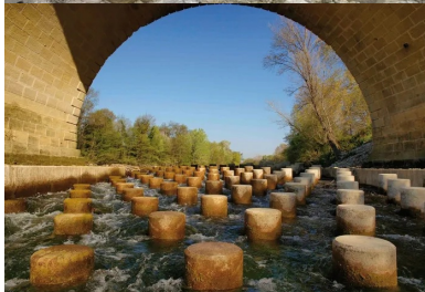
Les 113 cylindres de béton cassent la dynamique de l'eau et permettent aux poissons de se reposer lorsqu'ils remontent le courant.
