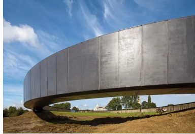
Il est posé en équilibre sur la ligne de crête, d'ou un porte-à-faux de 60 m.
