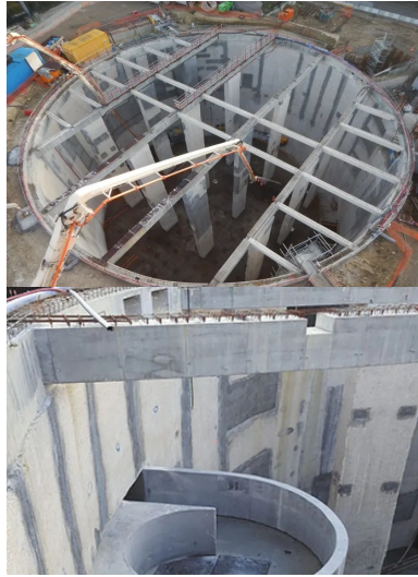
12 barrettes portent les poutres, supports de la couverture en béton.
