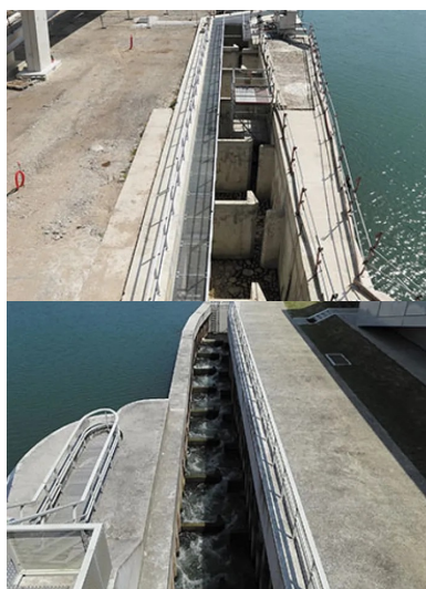
Passes à poissons à chambres successives dans les barrages de vives-eaux et Chatou.
