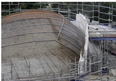
Ferrailage de la coque en béton armé, après la projection par l'intérieur, la projection par voie humide par l'extérieur peut débuter.
