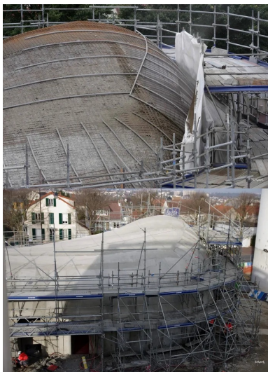
Ferrailage de la coque en béton armé, après la projection par l'intérieur, la projection par voie humide par l'extérieur peut débuter.
