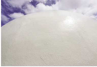
Le grain de la structure : une résine imperméabilisante de 2 mm, projetée au pistolet.
