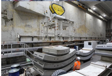
Puits d'entrée du tunnel, manutention des voussoirs de 6 tonnes chacun.
