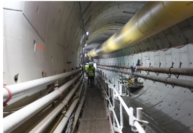
Intérieur du tunnel avec la conduite de marinage pour l'exfiltration des déblais et la canalisation de boue bentonitique.
