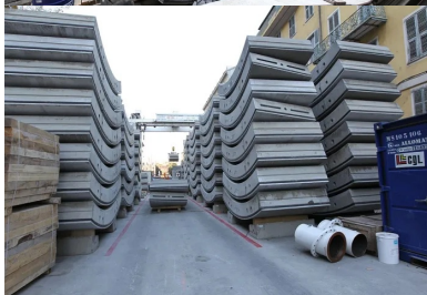
Rue Ségurane : sur la zone de chantier, stockage des voussoirs en flux tendu, en raison de l'exiguïté des lieux.
