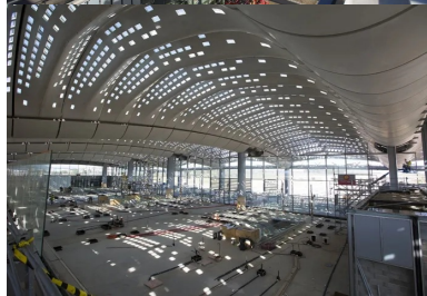
En sous-face, les coques habillent la structure et forment avec les palmes une surface à double courbure.
