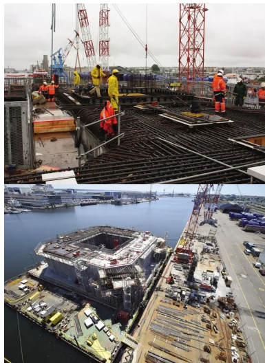
Travaux de mise en place des armatures sur le pont du flotteur.
