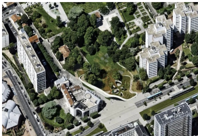
Végétalisée en toiture, la gare de Vitry prolonge le parc.
