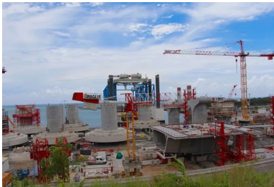
Une fois leur phase de maturation terminée, les embases et têtes de piles sont embarquées directement depuis l'aire de préfabrication sur la barge (au fond en bleu) qui les mettra en place.
