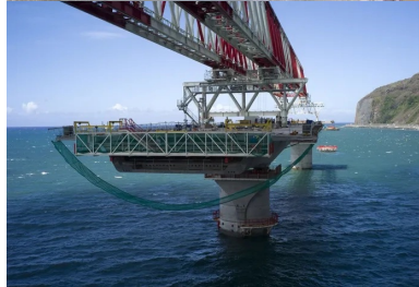
Appuyée sur les piles déjà en place, la poutre de lancement géante est capable d'assembler un fléau complet avant de se déplacer vers sa position suivante.
