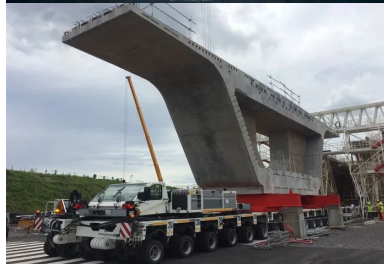
Les voussoirs sont acheminés depuis l'aire de stockage jusqu'à leur lieu de pose sur des fardiers munis de 216 roues !
