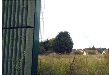
Montés seuls ou par deux, l'un sur l'autre, les panneaux protègent les zones résidentielles des tronçons où la circulation est la plus bruyante
