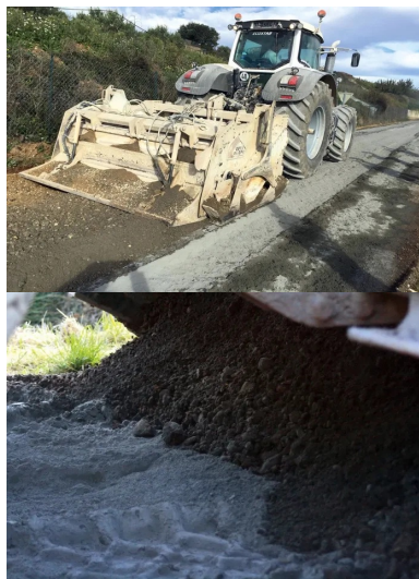
En action sur le chemin du Bousquet, en octobre 2015, le « tracteur muni d'un malaxeur » loué à la société nîmoise Ecostab, spécialisée dans le traitement des sols.
