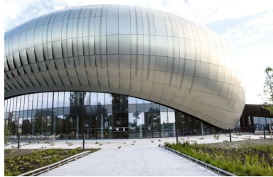
Autour de la Cité du Vin, le parvis et les cheminements ont été réalisés en béton décoratif : plus de 4 000 m 2 au total.
