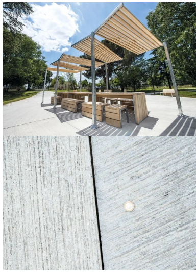
Les « stations vertes » des Sècheries : des aires de repos ou d'animation, dotées de mobilier et desservies par les cheminements en béton balayé.
