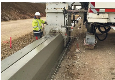
Mise en œuvre d'un caniveau à fente.
