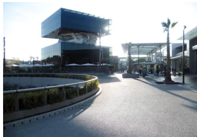
Les voies piétonnes et le parvis des magasins de Polygone Riviera ont été réalisés en béton micro-désactivé par la société MB Constructions.
