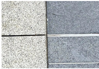
Mariage réussi entre la dalle sombre et le béton désactivé clair.
