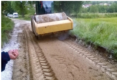
Une fois le compactage partiel réalisé, un réglage définitif et un compactage final parachèveront l'intervention, avant la mise en place d'un enduit gravillonné de protection et la réalisation de la structure de chaussée définitive.
