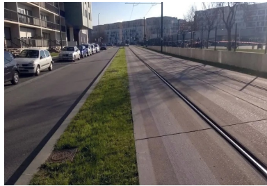
La plate-forme du tramway T6 est constituée d'une dalle courte en béton non armé et goujonné
