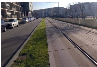
La plate-forme du tramway T6 est constituée d'une dalle courte en béton non armé et goudonné
