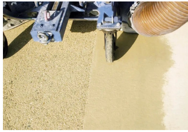
Pour le traitement de la couche de roulement, c'est la technique de l'hydroprojection qui a été retenue
