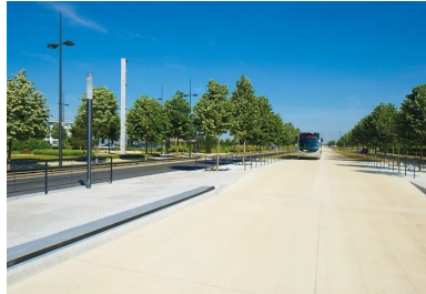
La voie dédiée au BHNS se distingue des voiries existantes par sa couleur claire.
