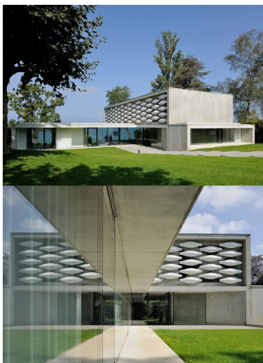
Le premier étage s'élanç en direction du lac par un généreux porte-à-faux
