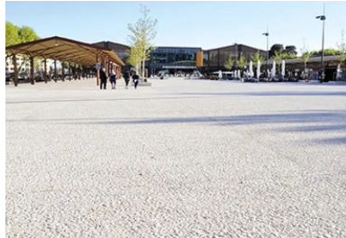
/ Vue générale de la place Jules-Morgan. Au premier plan, le béton de granulométrie 20/40
