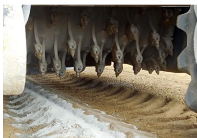
La puissance du rotor du malaxeur garantit une bonne homogénéisation verticale et transversale du mélange liant hydraulique-matériau fragmenté de l'ancienne chaussée
