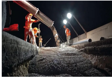
La minéralisation du TPC de l'A47 a été réalisée avec du Rempleco, produit fluide de remblayage et d'élargissement de Colas.
