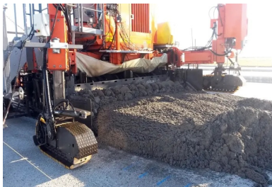
La Wirtgen SP-500, équipée de goudonneuses latérales, en action. Grâce à ses capteurs, elle permet une précision de l'ordre de 5 mm.
