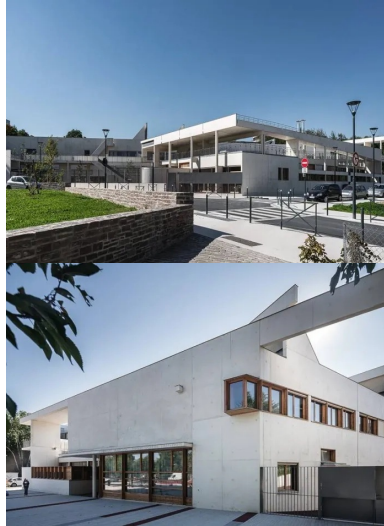
Angle sud-est, la salle de sport dispose d'une entrée en relation directe avec la rue, côté sud, a n de pouvoir servir aussi indépendamment de l'école.
