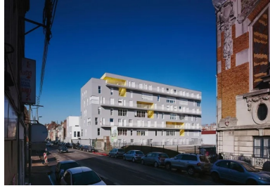
Chacun des deux immeubles s'inscrit dans le gabarit de ses voisins.
