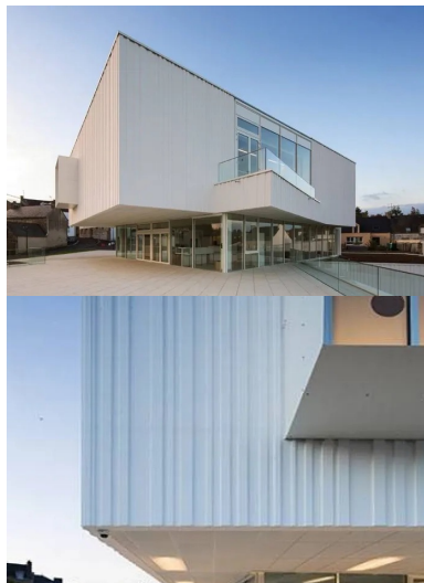
Un vaste belvédère est créé dans la continuité du hall d'accueil.
