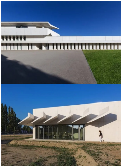
La modénature de la façade, constituée d'éléments préfabriqués en béton blanc, assure des protections solaires passives aux baies.
