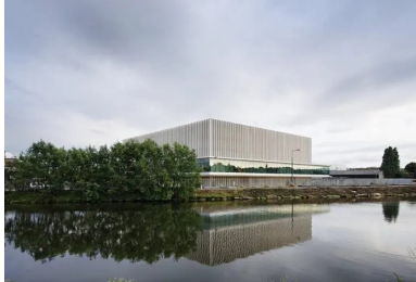
Façade nord sur le canal. Le choix de matériaux pérennes et le soin de leur mise en œuvre participent de l'image du palais, entre les fines colonnes de béton, la double peau vitrée assure un tampon thermique.
