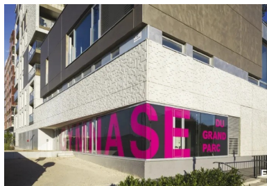
Jeu de contraste entre les panneaux de béton blanc et les panneaux de béton lisse recouverts d'une peinture métallisée.
