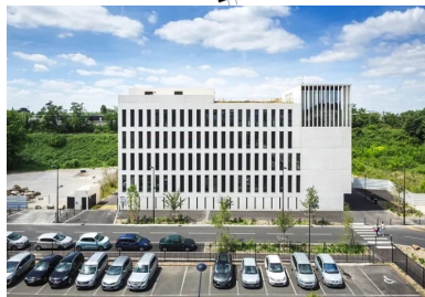
Le dessin des façades en béton poncé exprime la rigueur du plan.
