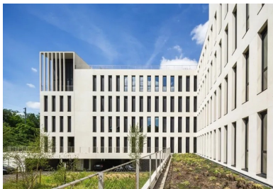
Une pergola accessible double la façade nord.
