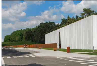
Le mémorial, installé sur la crête, et le volume du centre d'accueil s'alignent pour former l'axe de mémoire.
