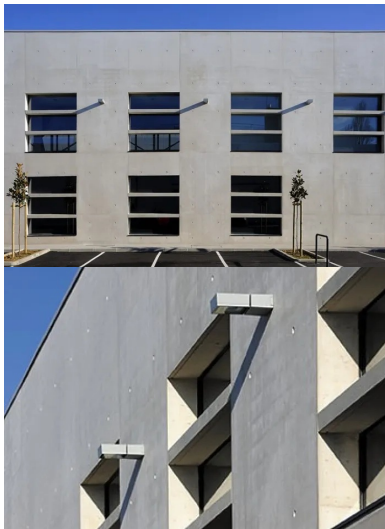
Façade sud, des brise-soleil en béton préfabriqué protègent les ouvertures du rayonnement tout en participant à leur redécoupage.
