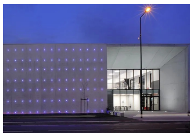
Outre leur intérêt graphique, les leds insérées dans les trous de banche participent au rôle de signal du bâtiment.
