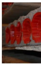
Figure 11 : exemple de planchers alvéolaires précontraints.
