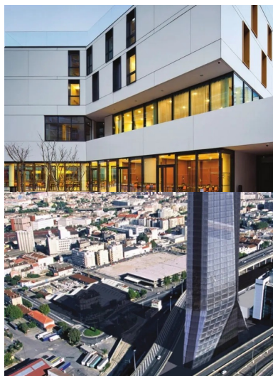
Maison de retraite EPHAD Annie Girardot, Paris. Ce projet, pilote pour la mise au point du référentiel de certification Habitat & Environnement EHPAD, porte une attention particulière au confort et à l'accessibilité des occupants, population qui doit pouvoir disposer d'un temps d'évacuation adapté à ses vulnérabilités.
