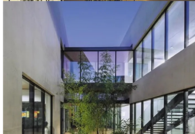
le patio qui sépare les deux parties du bâtiment est à la fois un puits de lumière et un espace de liaison.
