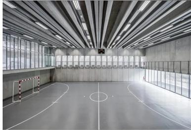
À l'intérieur, le bâtiment est rythmé par la trame de 1,80 m, sur laquelle est calé l'ensemble du bâtiment et notamment la succession de poutres précontraintes qui soutient la toiture.
